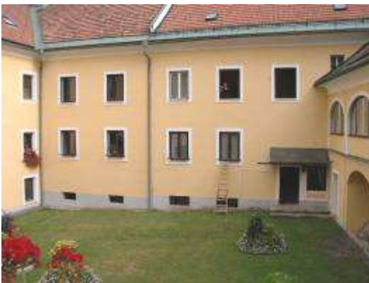
Fenstertausch im Verwaltungs- gebäude
